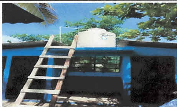
Foto 3: Instalación de Rotoplast.
