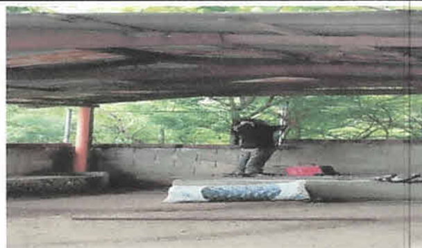
Foto 4: Reposición de malla.
