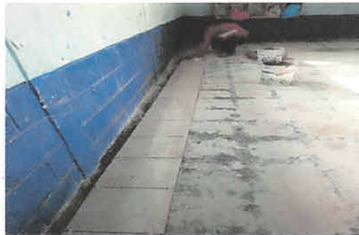
Foto 2: Colocación de Piso en una aula y corredor del establecimiento.
